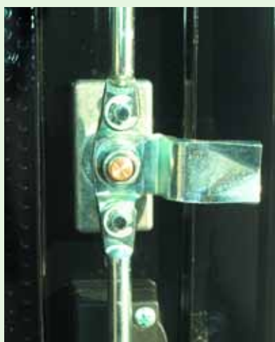
Trójpunktowe ryglowanie drzwi
