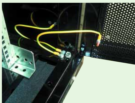
Uziemienie wszystkich części
