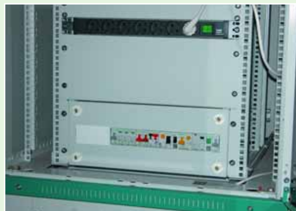
Możliwość instalacji zabezpieczeń (aparatura modułowa - wyłączniki nadprądowe, różnicowoprądowe, ochrona przeciwprzebieciowa, zegary sterujące itp.) wewnątrz rozdzielni cy sieciowej
